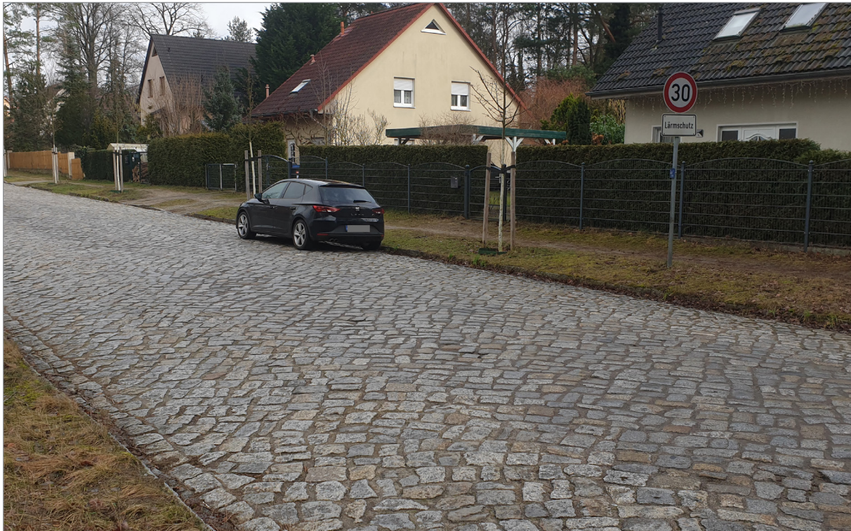
Abbildung 2-1 Rüdersdorfer Straße (eigene Aufnahme) | Blickrichtung Nordosten
